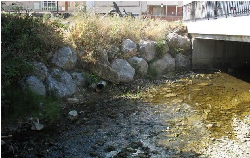
Figura 5-37. Escolleras en la localidad de Araia.
