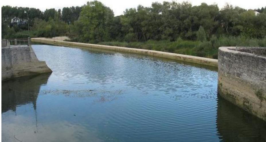
Figura 5-42. Azud de derivación del río Araquil en Ibero.
