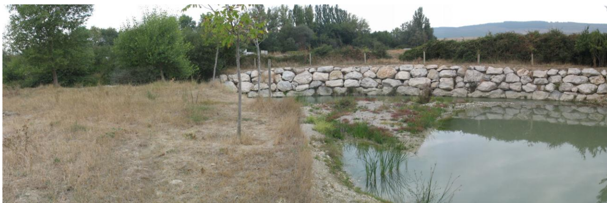
Figura 5-29. Afecciones en las riberas en la localidad de Otano.
