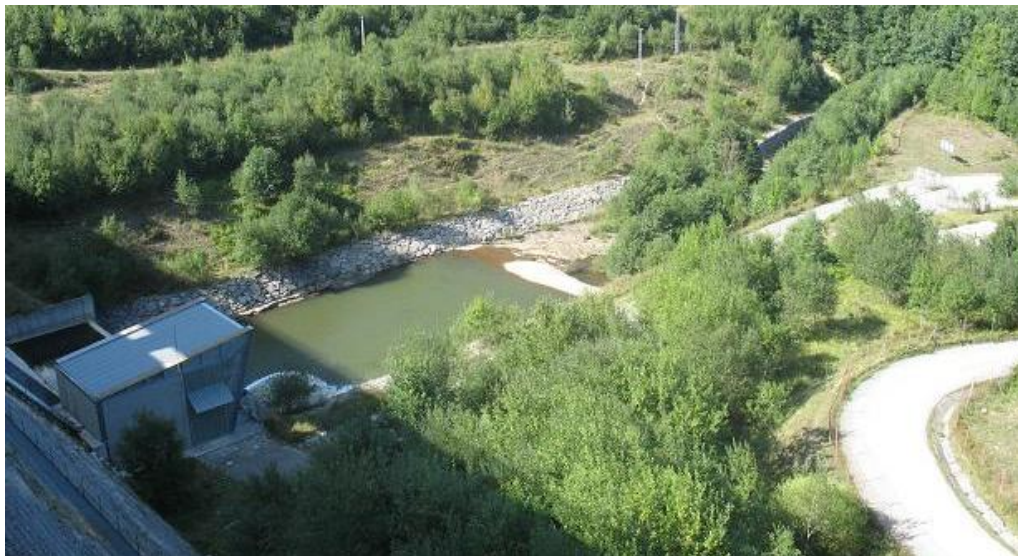
Figura 5-47. Alteraciones en el cauce bajo la presa de Urdalur.
