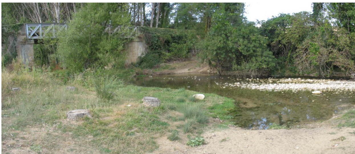
Figura 5-67. Puente y vado sobre el río Inaroz en su tramo medio.
