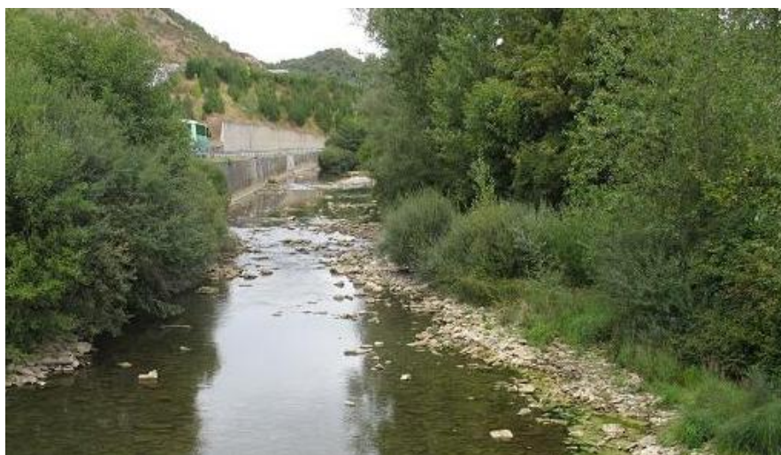
Figura 5-51. Corredor ribereño limitado por el paso de infraestructuras en Latasa.
