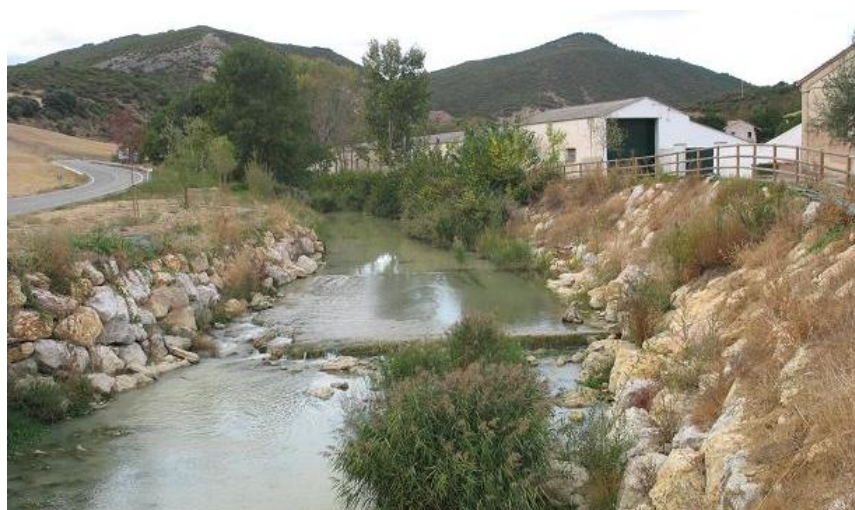
Figura 5-63. Escolleras laterales aguas abajo del embalse de Alloz.
