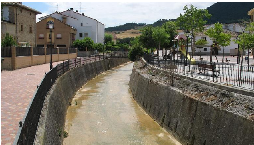
Figura 5-54. Canalización del río Robo en la localidad de Eneriz.
