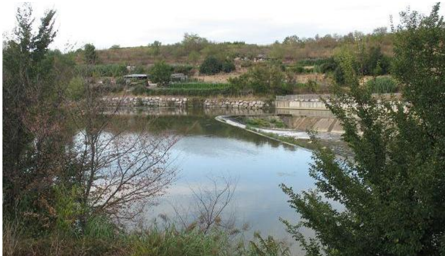
Figura 5-15. Azud aguas arriba de Puente la Reina.
