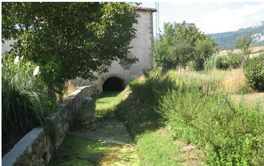
Figura 5-36. Canal de derivación.
