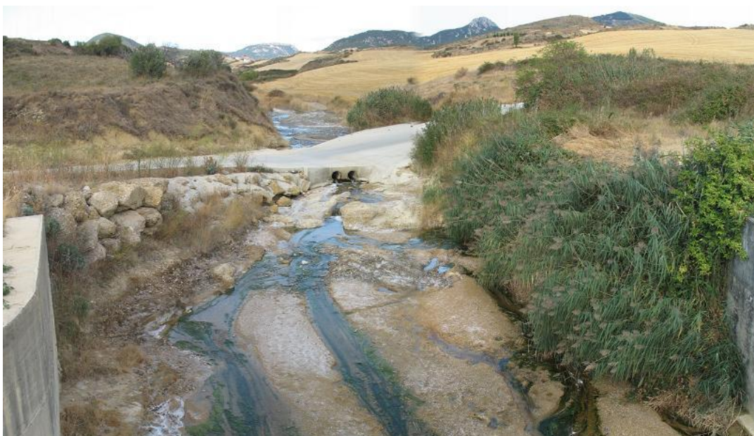
Figura 5-59. Vado y defensa puntual en el río Salado.
