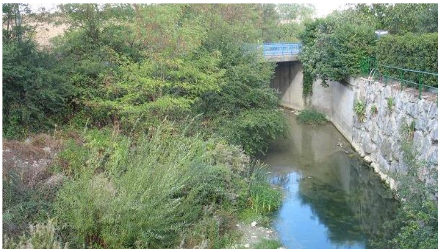
Figura 5-32. Defensas lateral y canalización del río Juslapeña en Arazuri.
