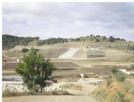
Obras en el Embalse de Lechago
