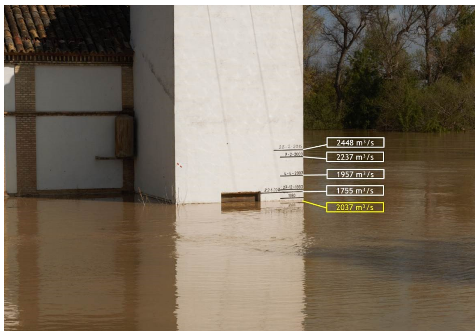
Figura 5: Nivel alcanzado en Boquiñeni durante la avenida de 2018. Las actuaciones llevadas a cabo han supuesto una mejora significativa de la capacidad de desagüe del cauce.
