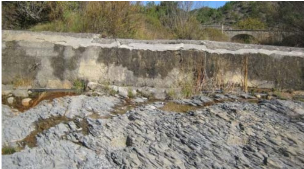
Fig. 5. Detalle de la tubería que discurre aguas abajo del sifón
