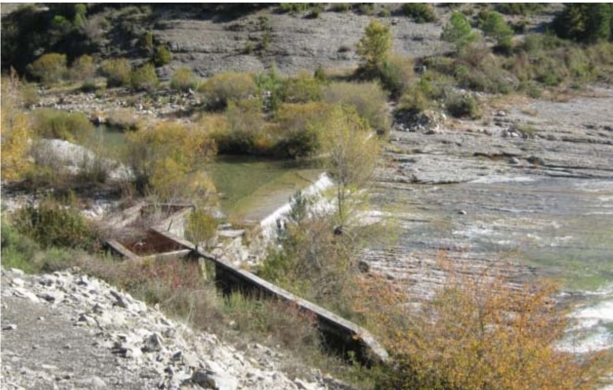
Fig. 9. Vista del sifón para cruzar el cauce del río Airés y de la acequia antes por la que se conducen los caudales antes de atravesarlo.
