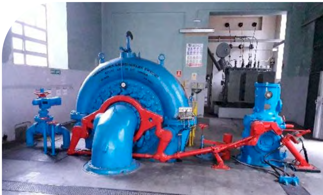
Turbina de la central de Castillonroy
