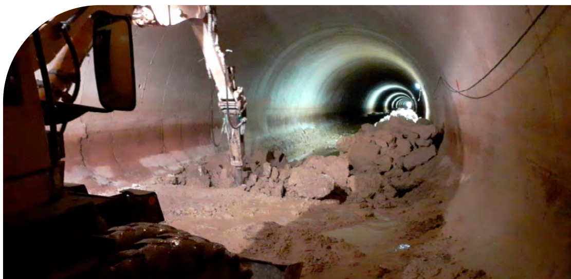
Mantenimiento del túnel de Farasdués
