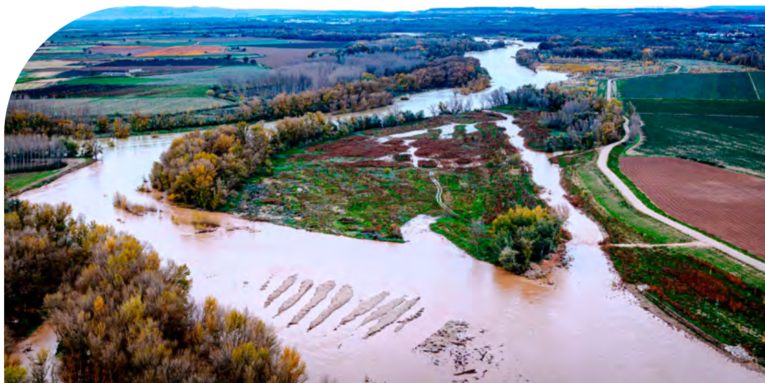
Retranqueo de mota y recuperación del espacio de movilidad fluvial del río Ebro en el paraje “El Ortigoso”. Milagro (Navarra)
