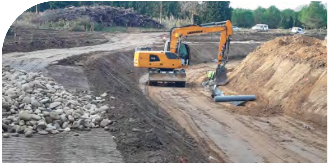
Excavaciones en emisario La Sotonera
