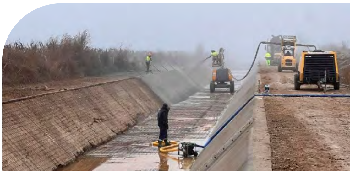
Gunitado del Canal de Aragón y Cataluña.
