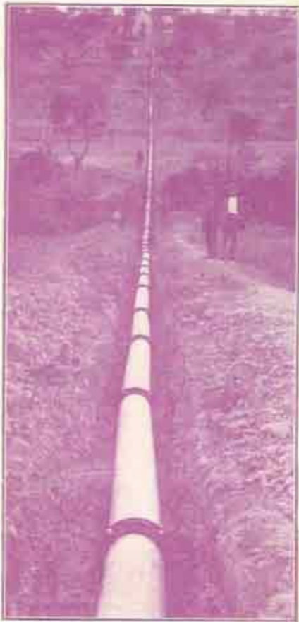
CONDUCCIÓN DE AGUAS EN CERVERA (Lérida) 1065 metros longitud. - 250 m/c diámetro. - 10 atmósferas
