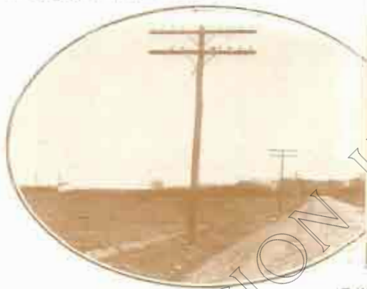
A lo largo de la carretera de San Sebastián- Zaragoza extiendense los postes telefónicos heraldos del progreso.
