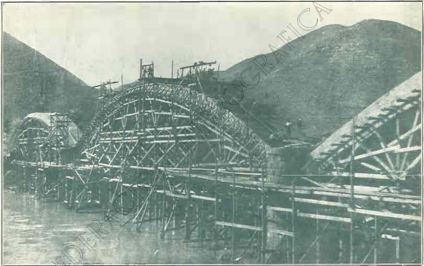
Puente en construcción sobre el río Ebro, en Mequinenza, con Cemento SANSON
